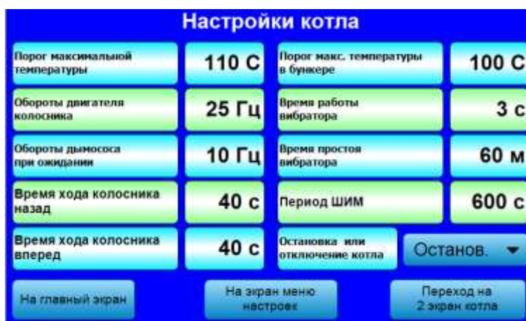
Рис 6. Экран настроек котла.
